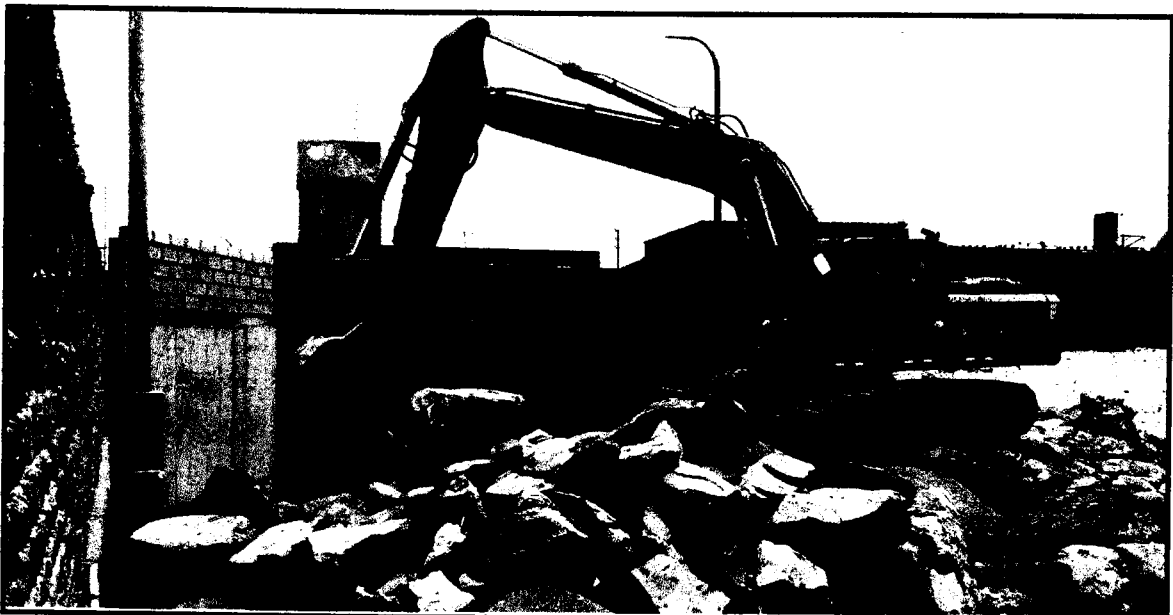
FOTO Nº 8 VISTA REPOCISION DE ENROCADO TRAMO 03 LADO IZQUIERDO.
