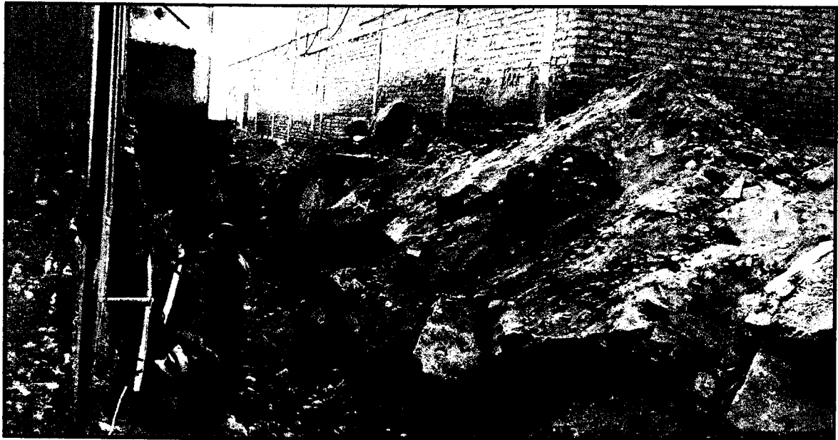
FOTO N° 1 VISTA PERFILADO DEL TERRENO EN TRAMO 02
